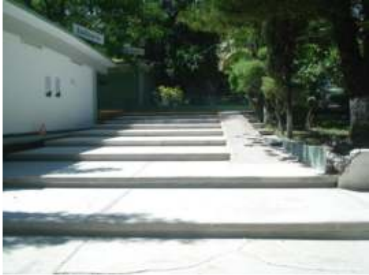
Escalinatas de acceso al plantel
