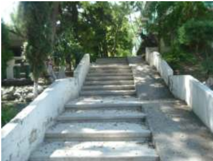
Escalinatas de acceso al edificio "D"
