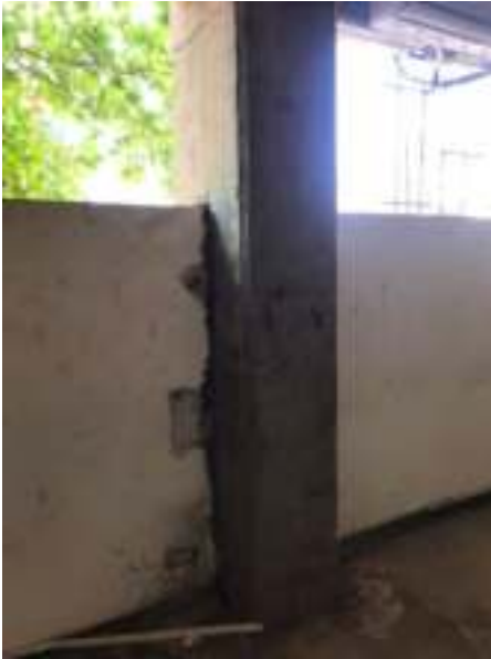
Reforzamiento de Columnas
