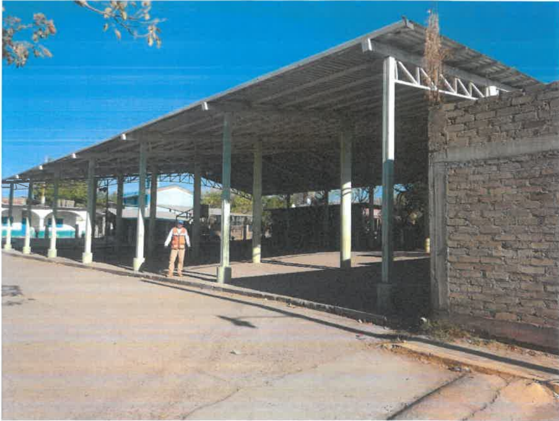
TECHADO MUNICIPAL DE SAN JERONIMO EL GRANDE , GRO. LATITUD NORTE : 18.213 LONGITUD OESTE : -100.505 ALTITUD : 282.82 MSNM
